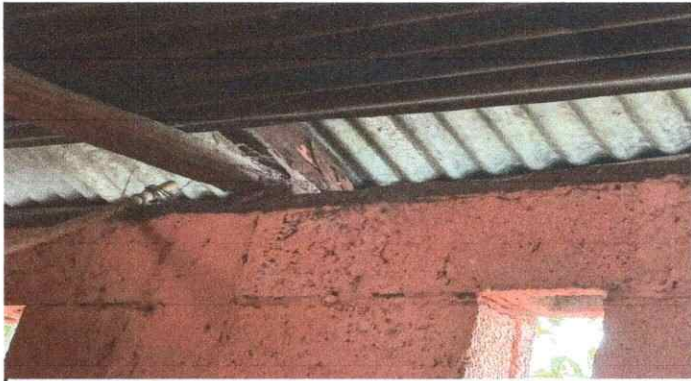
Foto 2: Se observa la estructura portante del modulo 1.
