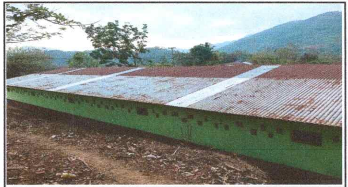
Foto 5: Se observa las ventanas portantes del modulo 2.
